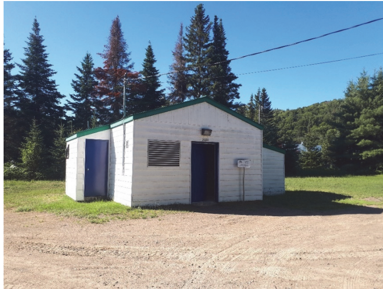
Photo 7 : Aperçu du bâtiment de production d'eau potable associé au site de prélèvement Xavier – 2020-07-15
