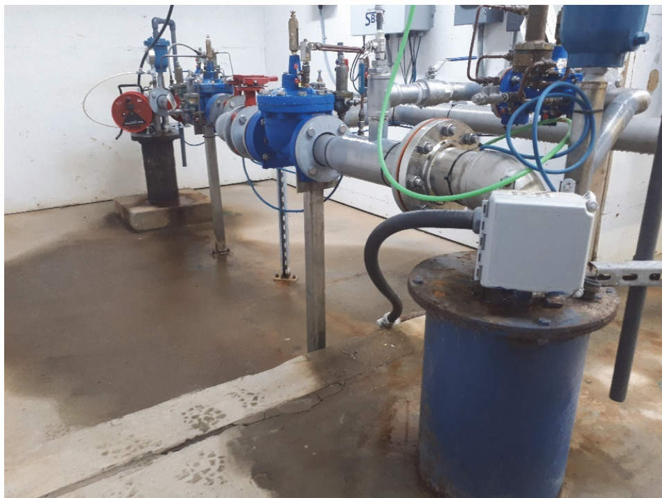
Photo 3 : Aperçu des puits Xavier - 2020-10-26
