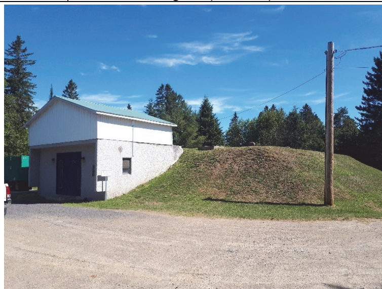
Photo 8 : Aperçu du bâtiment de production d'eau potable associé au puits St-Adolphe – 2020-07-15
