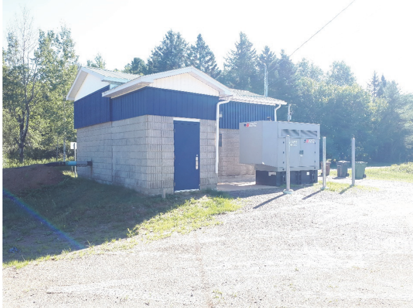
Photo 5 : Aperçu du bâtiment de production d'eau potable associé au puits Chicoine – 2020-07-15
